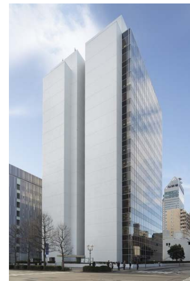
仙台キャピタルタワー
